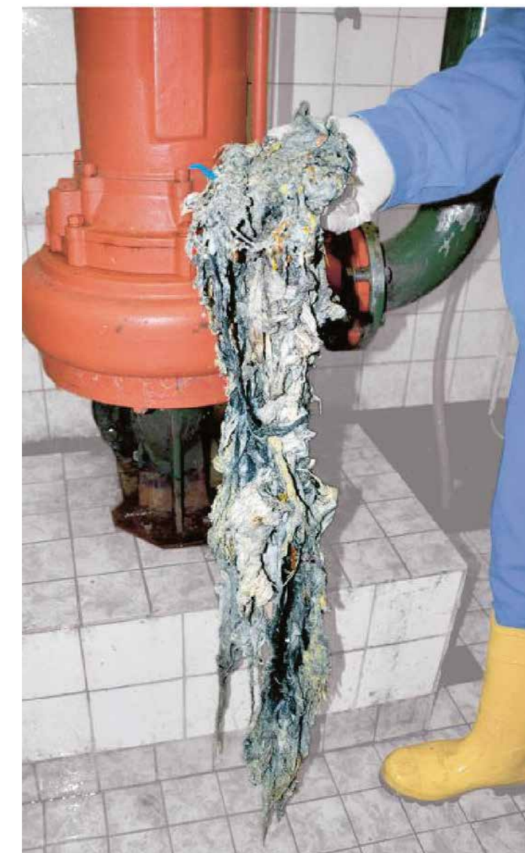
Aus dem Arbeitsalltag der SEL: Eine solche Verstopfung entsteht, wenn sich reißfeste Feuchttücher um die Pumpen wickeln.
